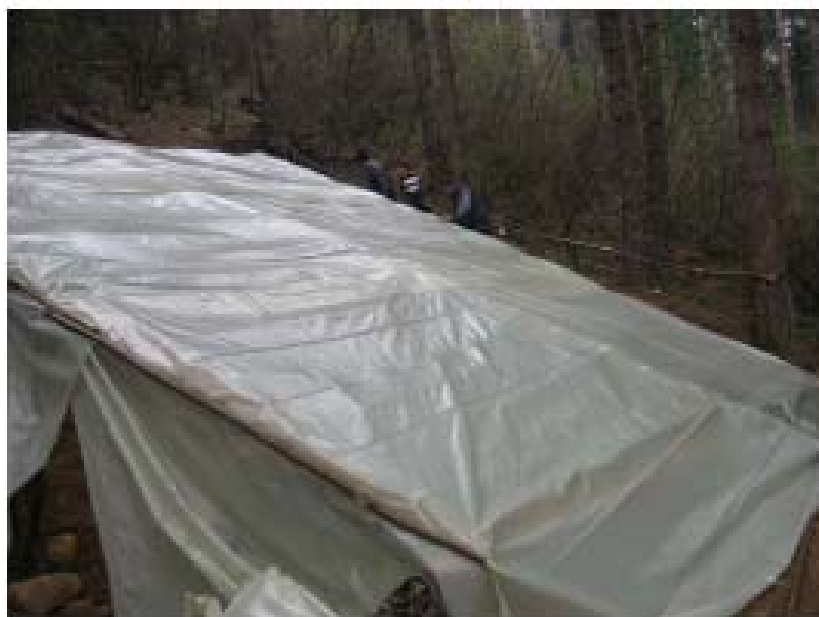
Sl.51 Završena zaštita sonde S-12, stavljenu najlon prekrivač i ogradjena zid (Photo: Špiro Gerao Čakčić, 05. novembar 2006)
