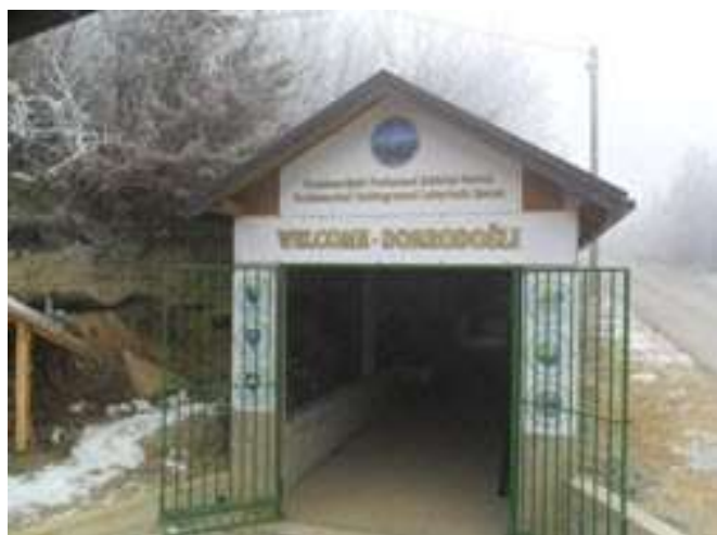
Slika 9: Vhod v predor Ravne
