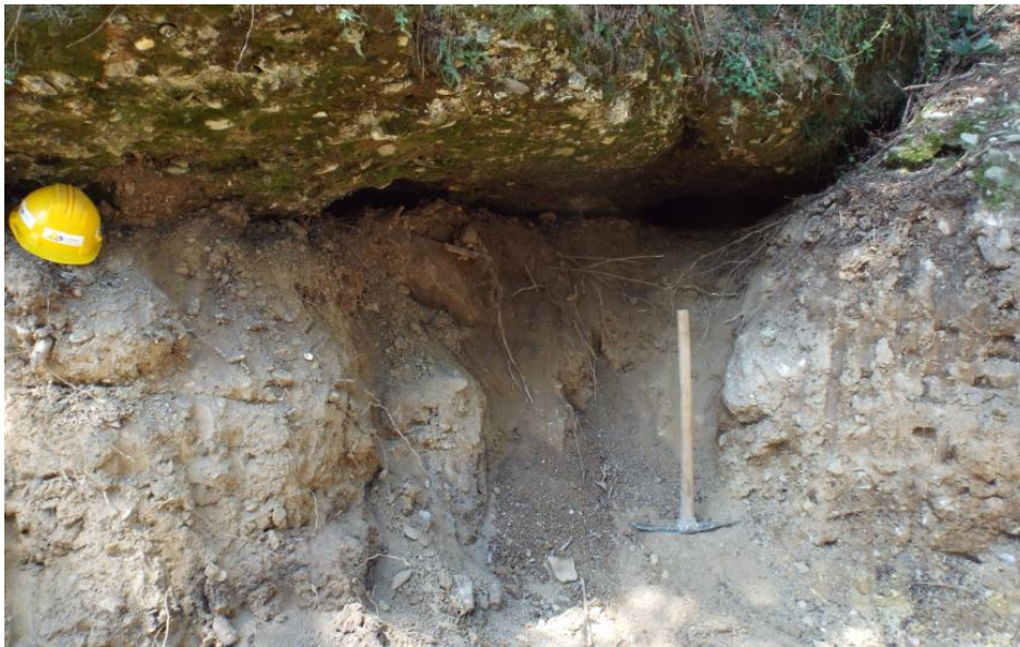
Slika 12. Krampa označava lokaciju nejasnog, ruševnog, ispunjenog prolaza između čvrstog konglomerata (strop), lapora (pod) i mekanog materijala kojim je ispunjen (zidovi).
