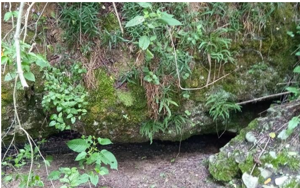
Slika 8. Otvor "C2" prije čišćenja. Razmak između tla i baze konglomerata je oko 15-20 cm. Prisutno je strujanje hladnog zraka iz ovog malog otvora koji očito izlazi iz većeg prostora.
