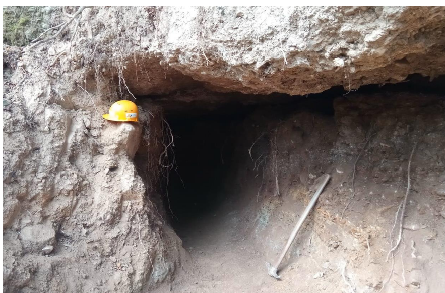
Slika 23. Ulaz „C3“ nakon čišćenja do 8m dubine tunela. U prolazu se vidi kako se zid spušta u podlogu od lapora. Visina tunela je približno 1,7 m i širina 1,5 m.
