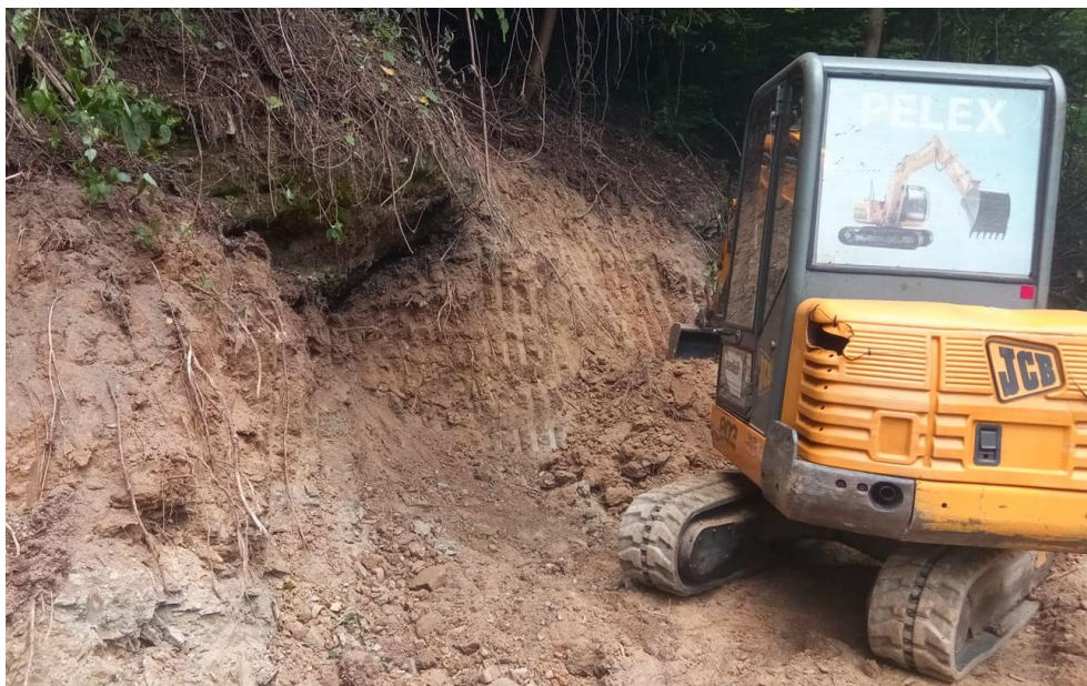
Slika 10. Zemljani radovi ispred otvora "C2". Uklanjanje površinskog sloja zemljišta i slojeva lapora ispod izbočina konglomerata.
