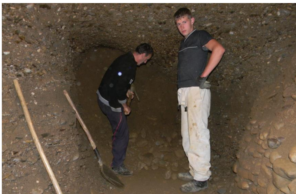
Slika 4. Čišćenje tunela Ravne 2010. godine. Rastresiti materijal je uklonjen. Konstrukcija suhozida zadržava materijal kojim je zablokiran bočni tunel (desno).
