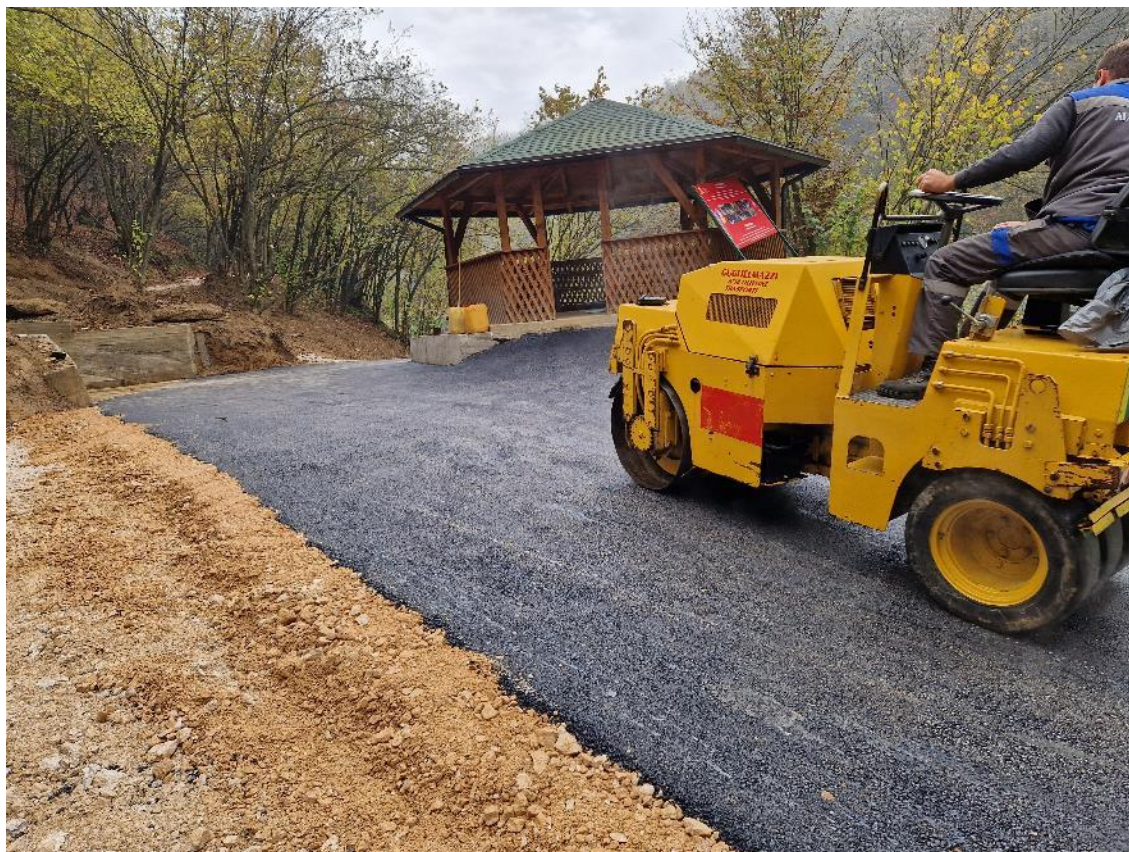
Slika 26: Uređenje pristupa tunelima Ravne 6, novembar 2023.
