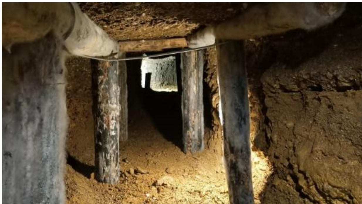
Slika 14: Otvoreni dio tunela Ravne 5 (foto: A. Agić)
