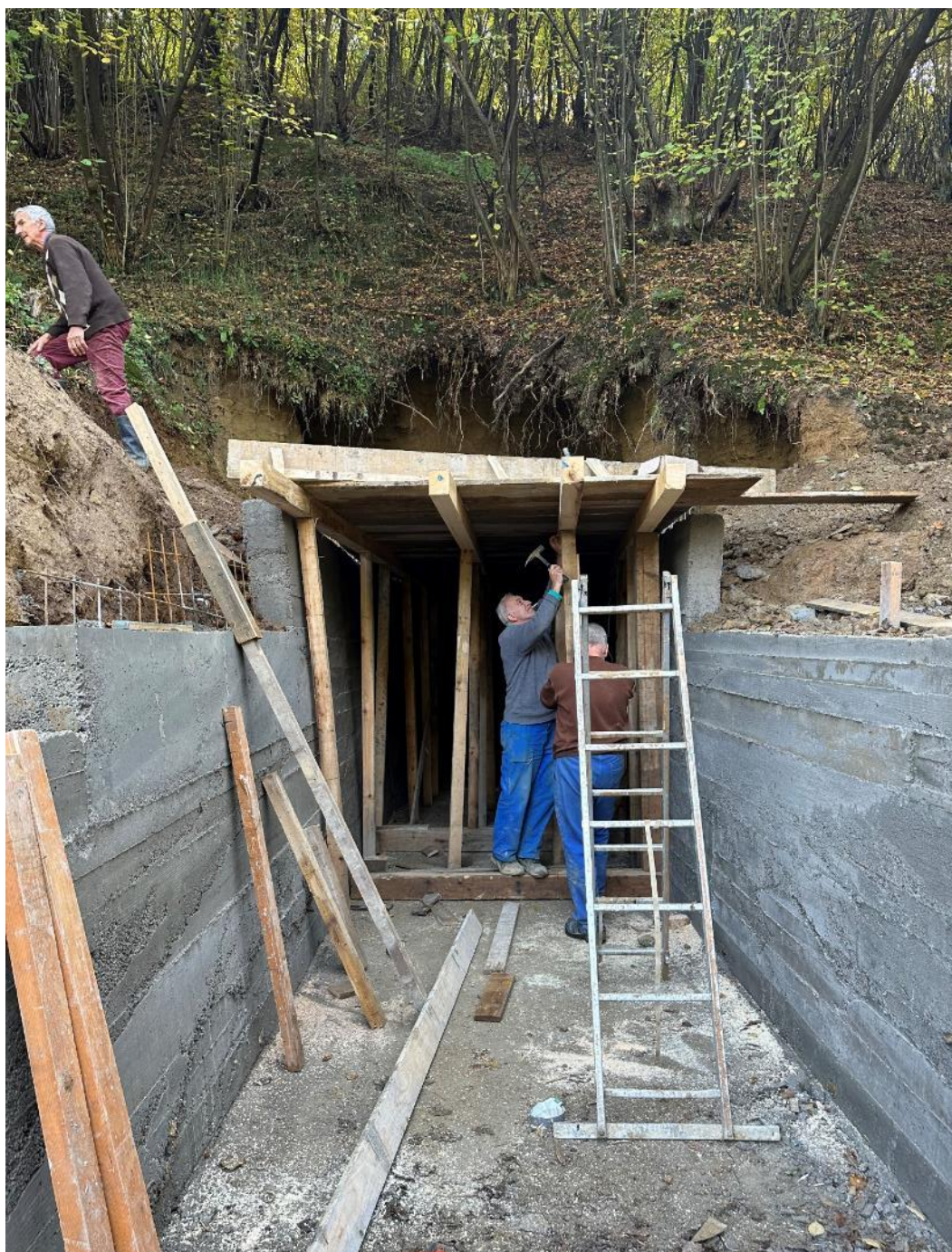
Slika 25: Rad na obezbjeđivanju arheološke lokacije tunela Ravne 6 (foto: A. Agić)
