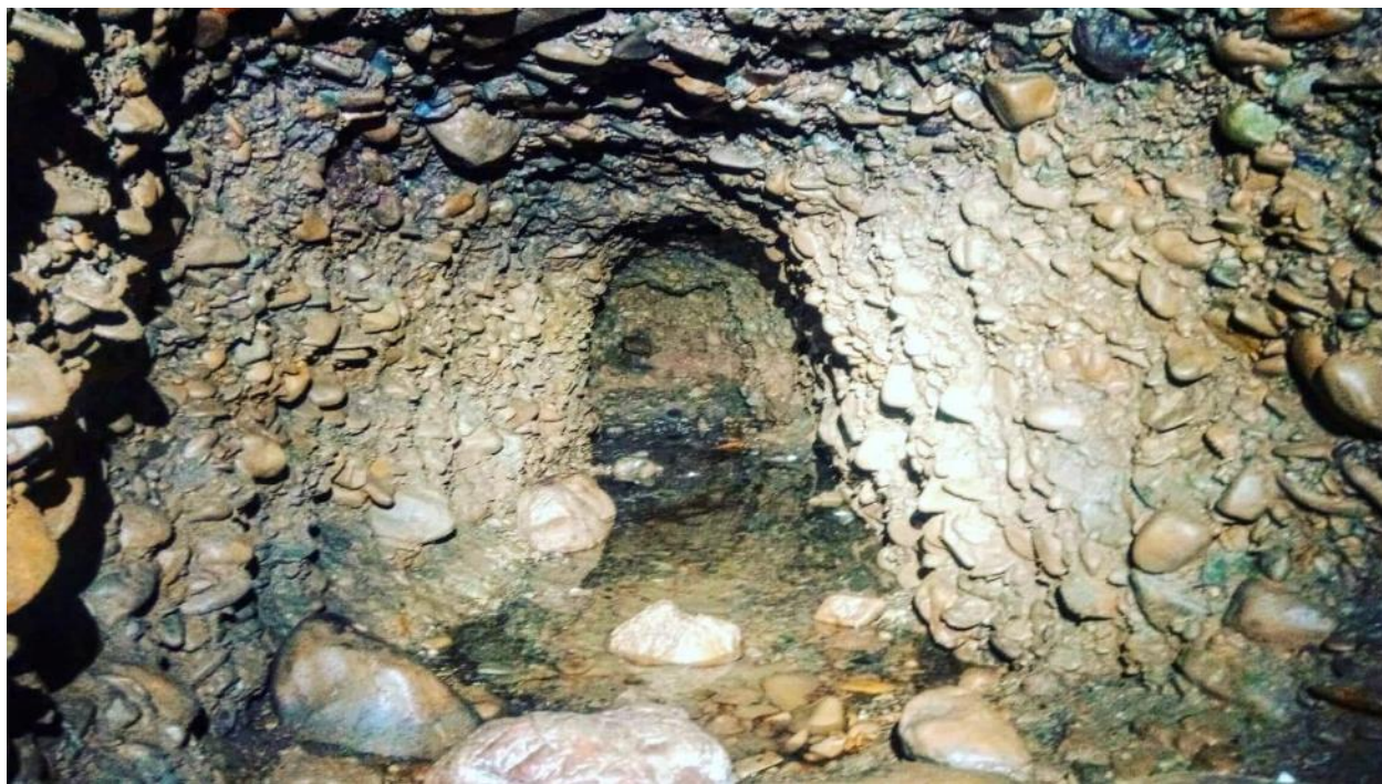
Slika 13: Unutrašnjost tunela Ravne 4, sekcija sa vodom (foto: R.Hoyle, 2019.)
