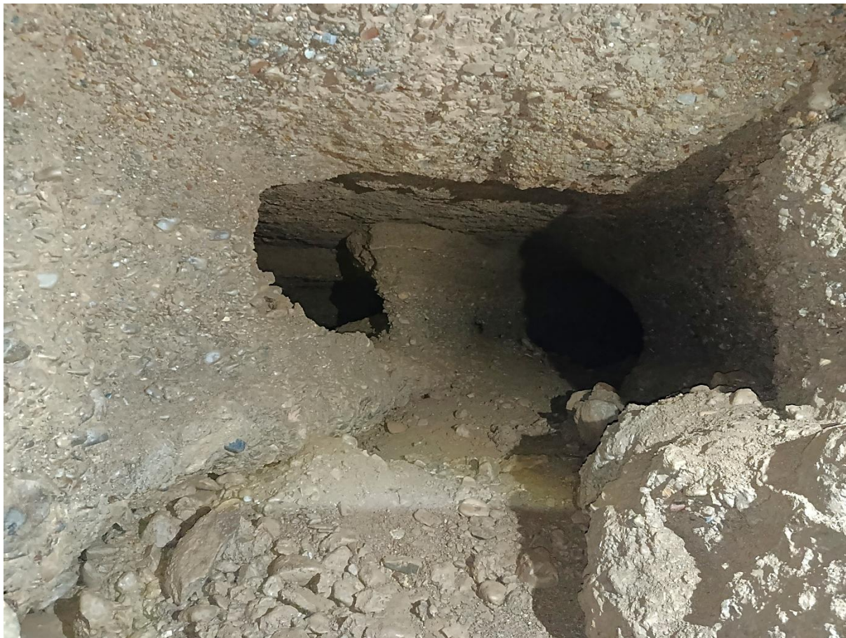
Slika 15: Zatečeno stanje novootkrivene sekcije tunela Ravne 6
