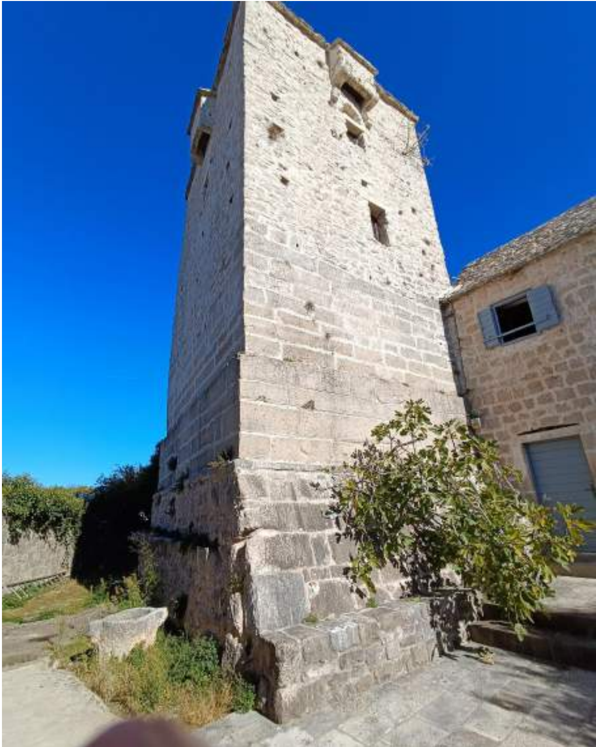
Mauzolej predstavljaju tri izvana vidljive sekcije. U donjoj je podzemna kripa, gornje dvije su mauzolej. Ulaz je iz zgrade u kojoj je smješten muzej.
